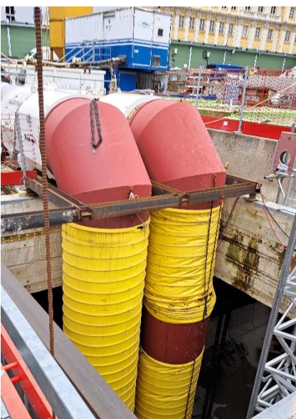
Belüftungsrohre der Tunnelbaustelle
