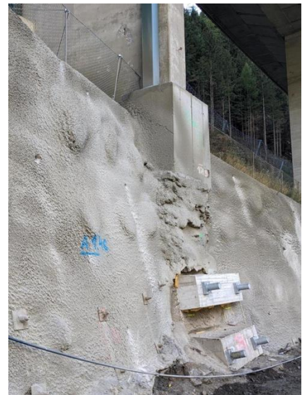
Sicherung eines Pfeilers in Zuge der Erstellung der Baustraße unter der Luegbrücke
