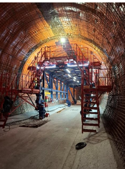
Bewehrung der Tunnelröhre
