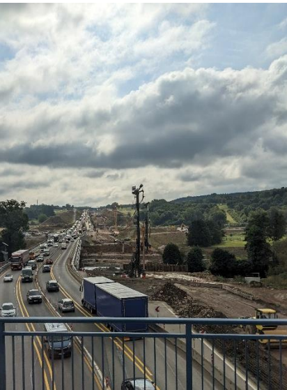
Verkehrsführung auf der Baustelle
