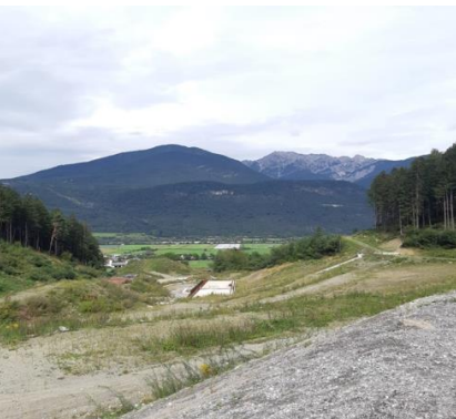
Gründung der Staumauer für das Retentionsbecken
