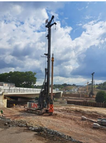
Bohrpfahlgerät im Flusstal der Enz
