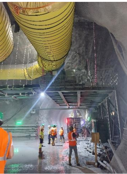
Blick in den Rohbau eines Verbindungsstollens
