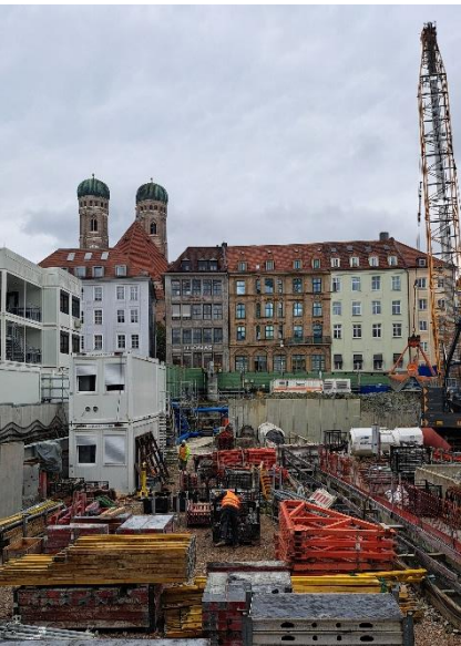
Baustelleneinrichtung auf dem Marienhof
