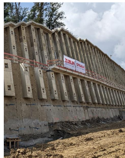
Lisenenwand zur Hangsicherung
