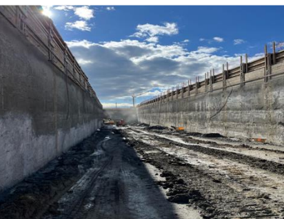
Trägerwandverbau mit Spritzbetonausfachung
