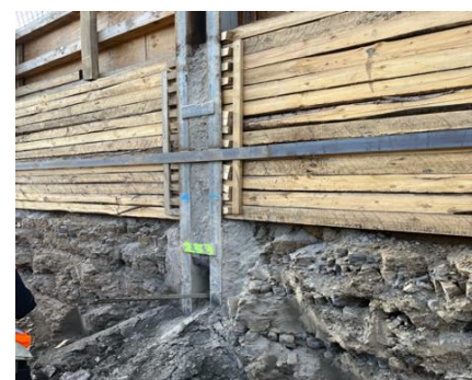
Wechselnde Bodenschichtung unterhalb der Trägerbohlwand
