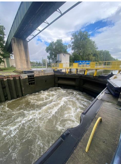
Schluessenkammer während des Schluessungsvorgangs
