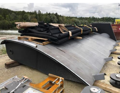
Wehr vor dem Einbau
