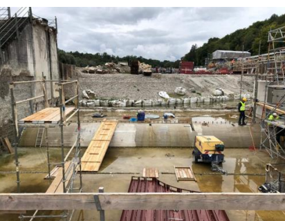
Bauarbeiten am Wehrfeld
