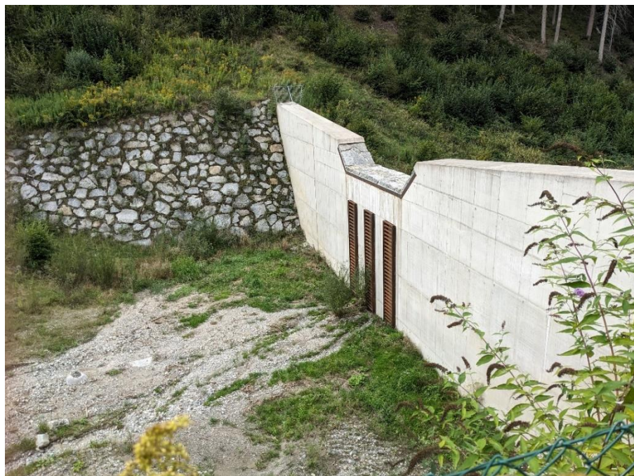
Flussaufwärts gelegenes Geschiebe-Rückhaltebecken
