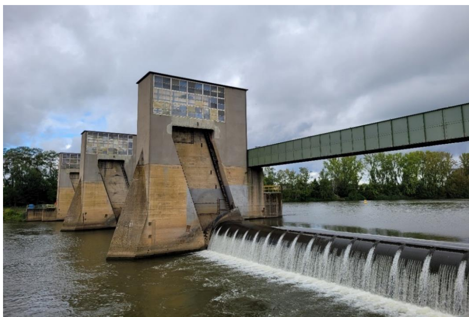
Die drei Wehrfelder der Staustufe Eddersheim
