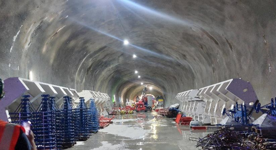
Die Montagekaverne für den Zusammenbau der TBM wurde im Sprengvortrieb hergestellt.
