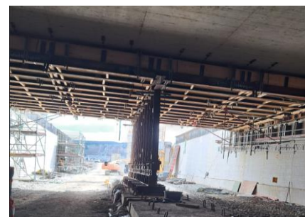
Schalwagen für die Betonage der Lärmschutzeinhausung
