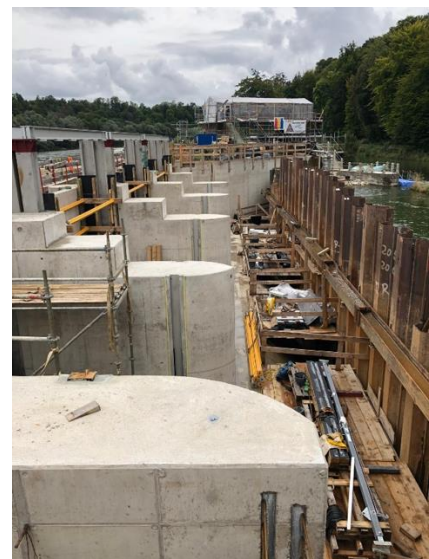
Bauarbeiten im Schutze einer Spundwand
