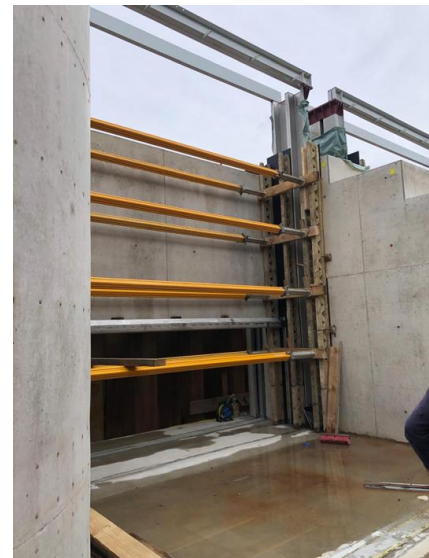
Bauarbeiten an einem der neuen Wehrfelder
