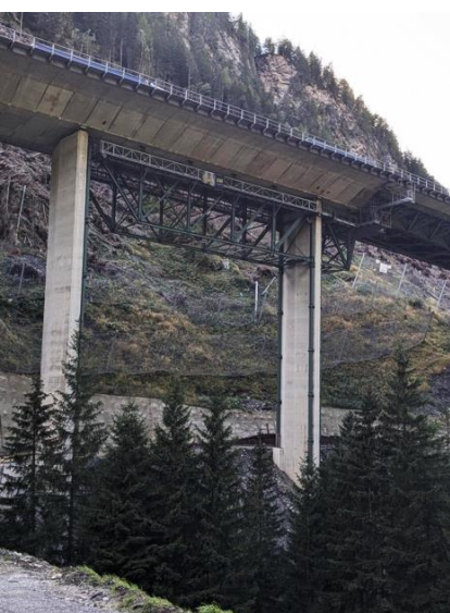
Fachwerk-Unterbau unter der Bestandsbrücke
