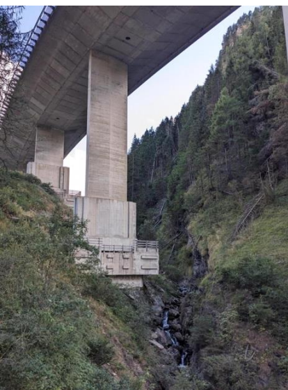
Pfeiler der Luegbrücke, gegründet im Berghang
