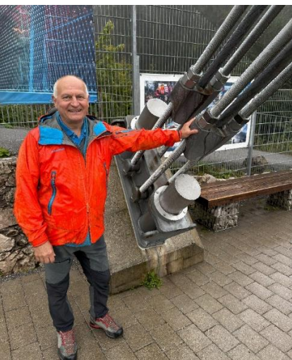
Verankerungskonstruktion der Tragseile
