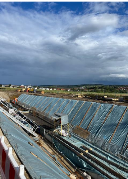
Abgeböschte Baugrube
